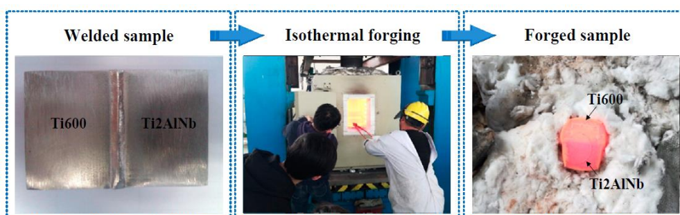
图 1 焊缝强化过程
